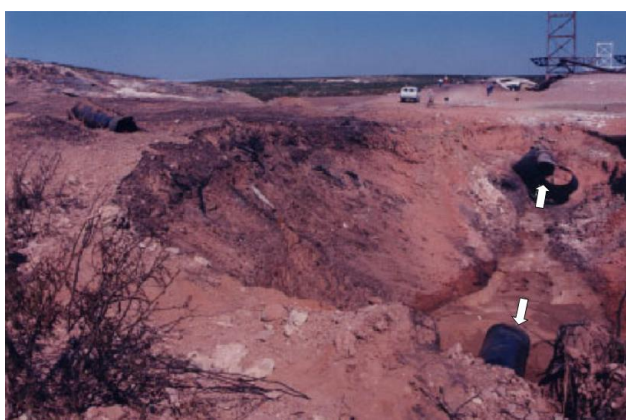
Figura 2 - Vista da cratera criada pela explosão, a secção que falta entre as setas foi arremessada pela explosão e dividida em três partes [1].
