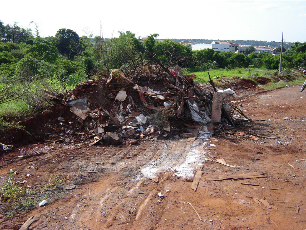
Foto 3.10 – Vista parcial – Rua Rio Madeira
