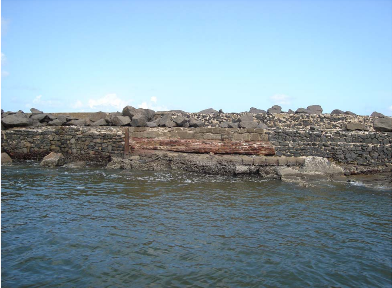
Foto 03: Estratigrafia do molhe: recife de arenito com camadas de blocos calcáreos, tijolos de barro, paralelepípedos e blocos de granito.
