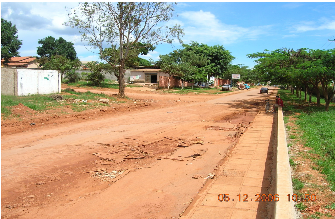
Figura nº. 15 – Foto Cruzamento da Rua 01-B com Rua 08, observando infra-estrutura precária
