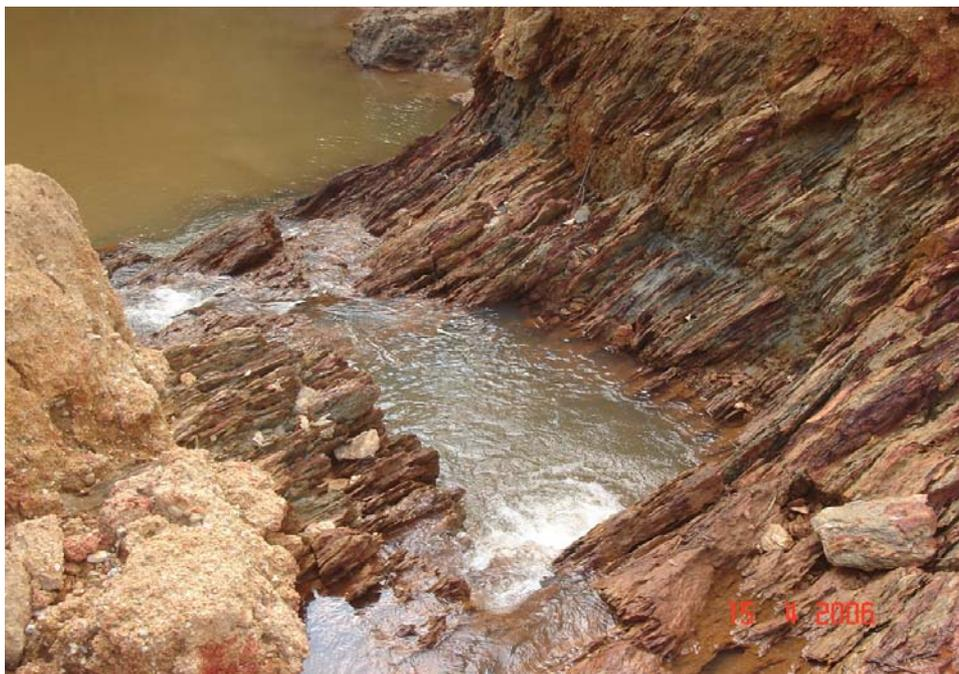
**Figura 3.12** – Filitos alterados devido à ação da água na margem esquerda, a jusante do eixo do barramento.
