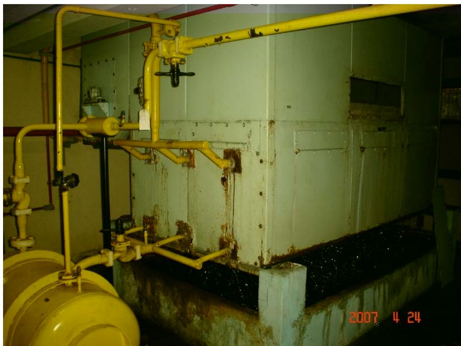
Figura 4 – Vista externa do condensador evaporativo
