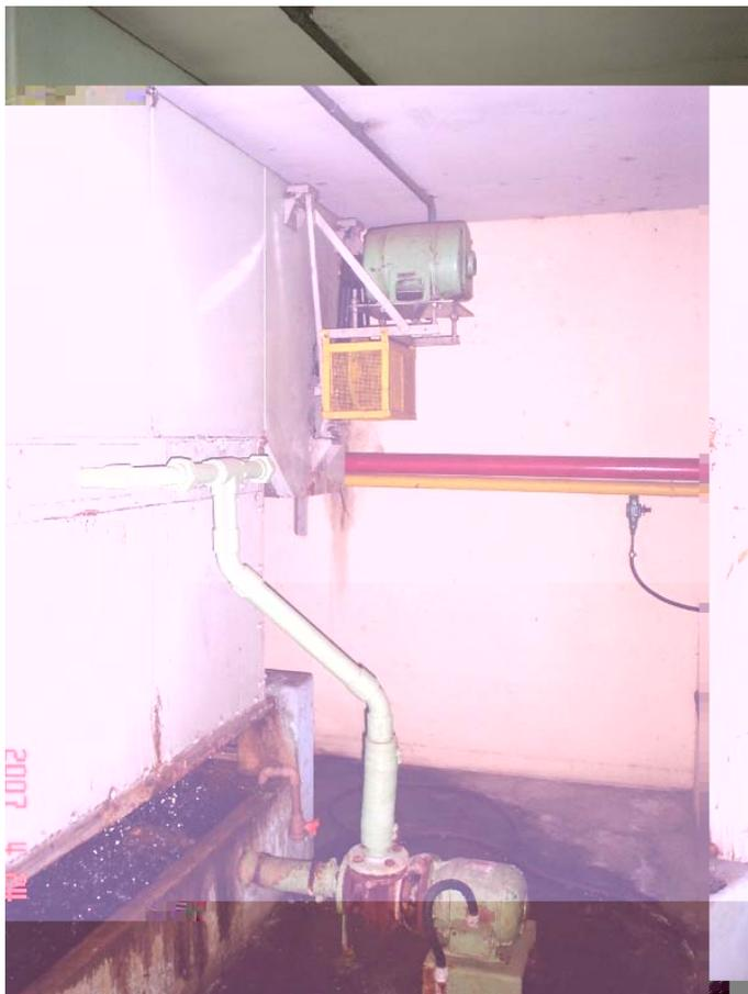
Figura 5 – Vista da bomba de circulação e da tubulação que conduz a água aos borrifadores.
