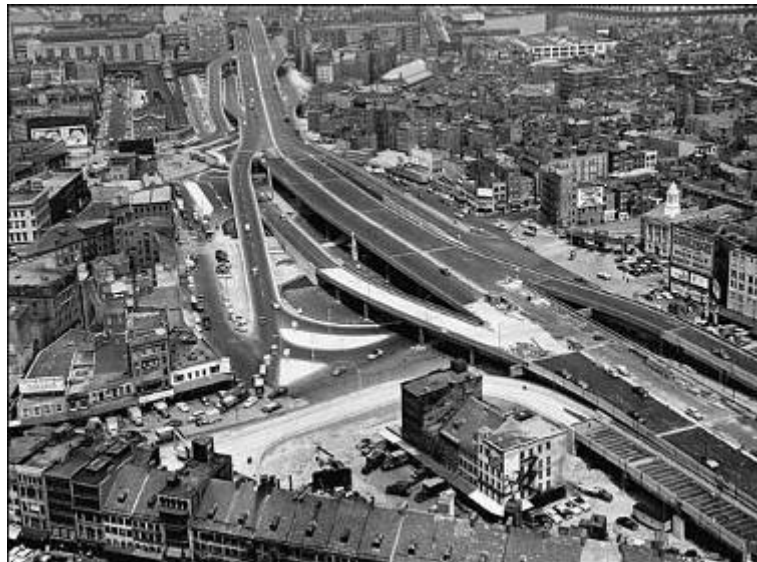
Figura 87: Central Artery em fase final de execução (1955)
