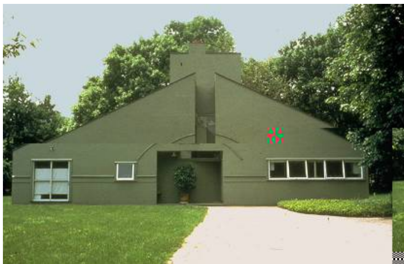
Figura 51: Vanna Venturi House (1963-1965) - Pensilvânia Arqt. Robert Venturi Fonte: Jencks (2002:viii)
