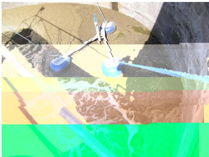
Figura 19. Aerador-misturador submersível que promove a oxidação e homogeneização da massa líquida.
