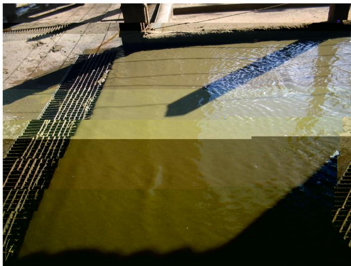
Figura 20. Canaletas de concreto que conduzem os dejetos líquidos aos tanques de aeração.
