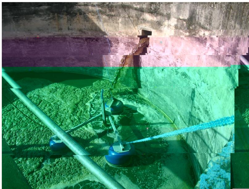
Figura 18. Tanque de aeração recebendo os dejetos líquidos através da canaleta.
