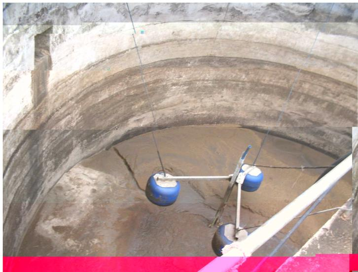
Figura 28. Reator 2, vazio, no qual se iniciará o processo de enchimento.
