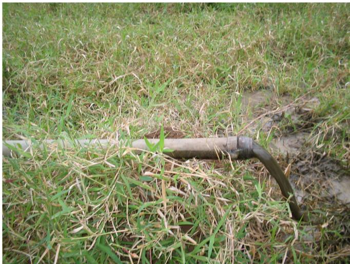
Figura 21. Tubulação responsável pela disposição do efluente líquido tratado sobre o solo.
