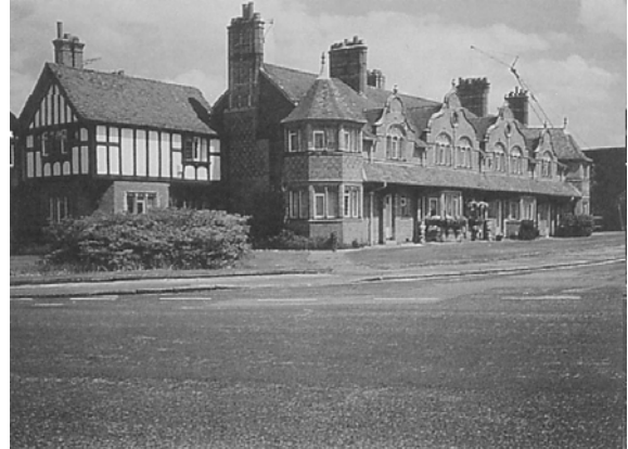
Figura 4.1.3: Moradia de operários em Port Sunlight . Fonte: CORREIA (1998).
