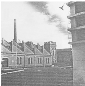
Fig. 3.2.12: N. Sra. Da Ponte. Fonte: SAIA (1988)
