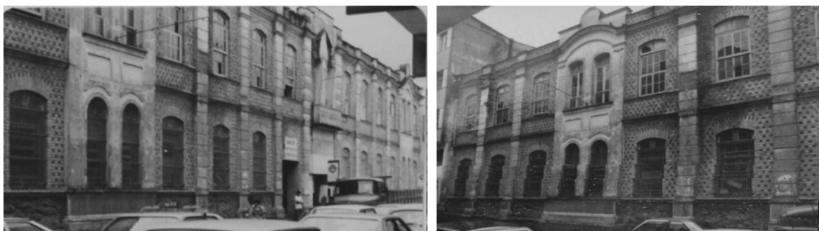
Figura 3.3.5.4: Seqüência de imagens da Companhia de Fiação e Tecelagem Santa Cruz. Fonte: PROCESSO nº 488516.
