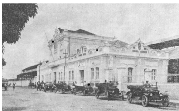
Figura 2.2.1.14: Estação em 1924 após reformas. Fonte: CARVALHO (1924).
