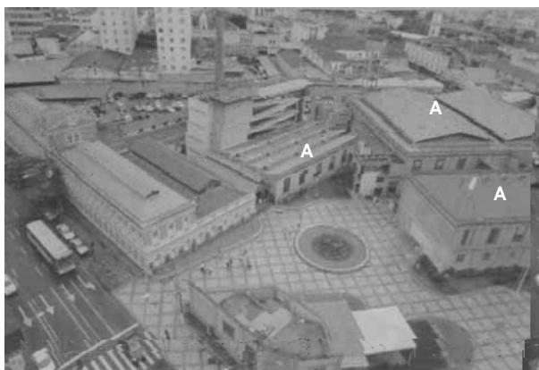
Figura 3.3.2.10: Edificações (A) da década de 1920. Fonte: Arquivo Biblioteca Municipal Murilo Mendes.
