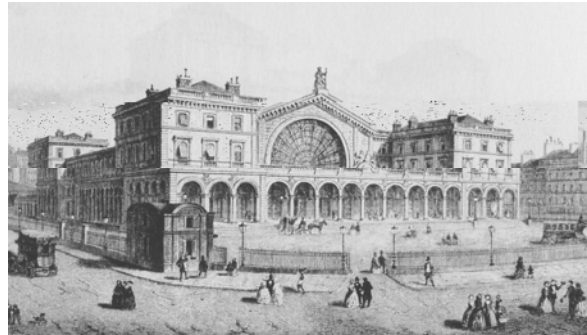
Figura 2.1.1.5: Estação da Estrada de l'Est em Paris. Fonte: PERDONNET (1856).
