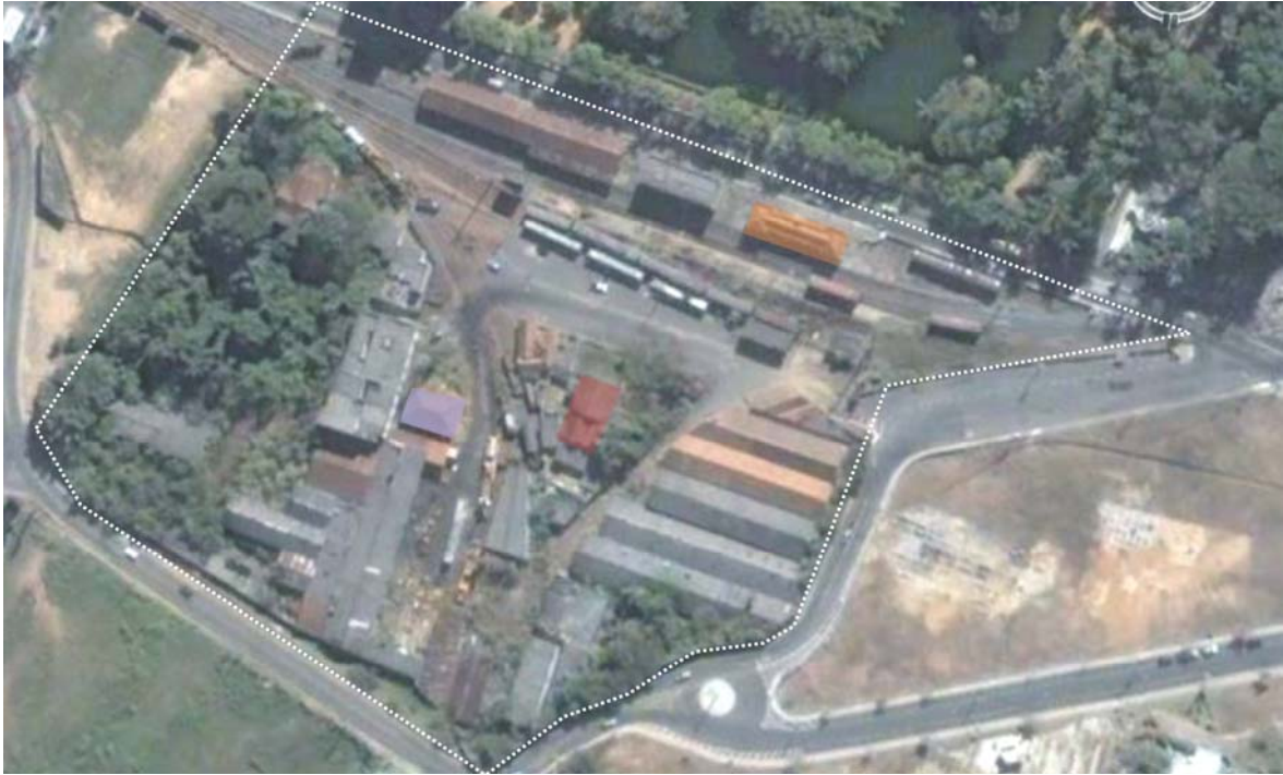
Figura 4.2.5: Vista do pátio da estação de Mariano Procópio.
