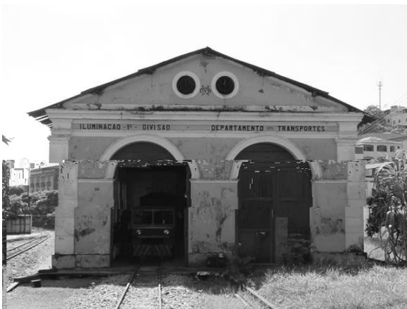
Figura 2.2.1.39: Edifício do setor de iluminação. Fonte: Foto da autora.
