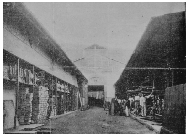
Figura 3.3.3.7: Oficinas. Ao fundo a entrada principal.
