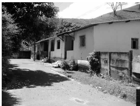
Figura 4.3.4.10: Casa tipo – Rua Mundo Novo. Fonte: Levantamento da autora.
