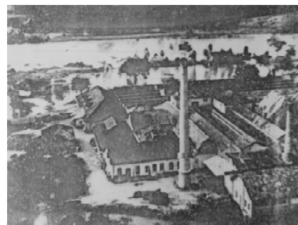
Figura 3.2.6: Fábrica Carioba. Fonte: BALLEIRAS (2003).
