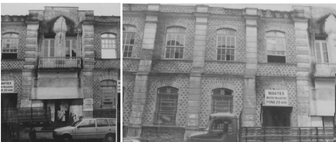
Figura 3.3.5.8: Seqüência de imagens da Companhia de Fiação e Tecelagem Santa Cruz. Fonte: PROCESSO nº 488516.
