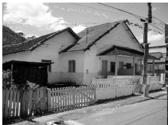
Figura 4.3.4.4: Edifício da pensão. Fonte: Levantamento da autora.
