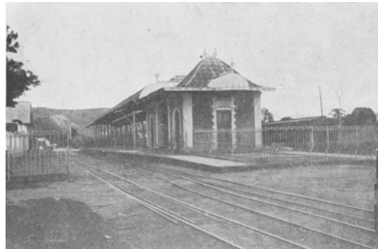
Figura 2.2.1.2: Estação suburbana de Chagas Dória. Fonte: CAPRI; BELLO (1918).
