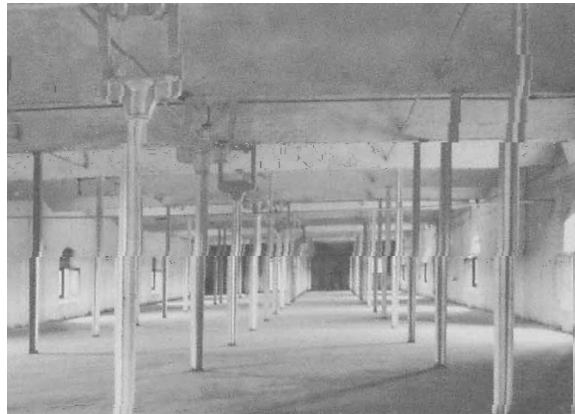
Figura 3.1.2: Fábrica Marshall, Benyon & Bage. Fonte: PEVSNER (1980).
