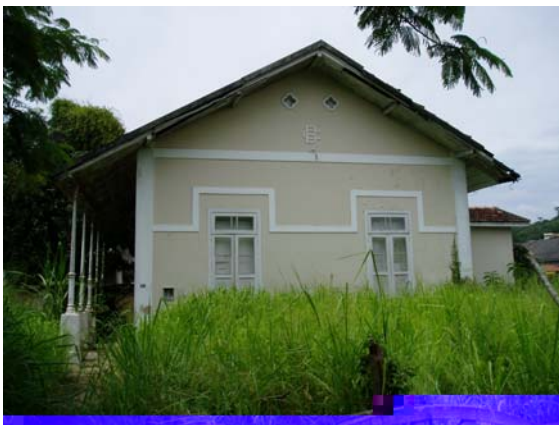
Figura 4.2.7: Residência do Chefe da Estação . Fonte: Levantamento da autora.
