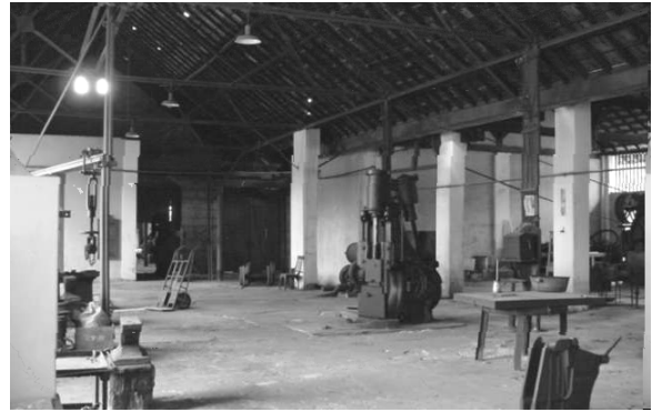
Figura 2.2.1.33: Vista interna da oficina de caldeireiros. Fonte: Foto da autora.
