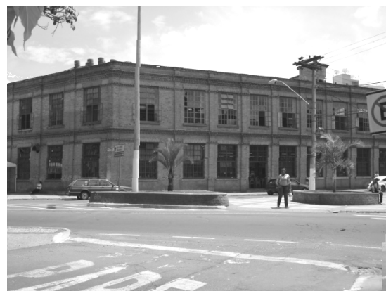
Figura 3.3.2.11: Detalhe do edifício da “nova fiação”. Fonte: Arquivo da Fundalfa.
