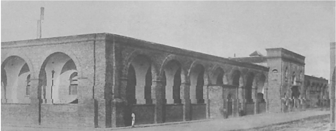
Figura 3.2.11: Fábrica de Camaragibe Fonte: CORREIA (1998).
