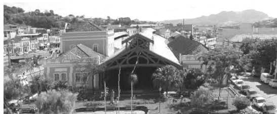
Figura 2.2.1.12: Estrutura metálica e os edifícios. Fonte: Foto da autora.
