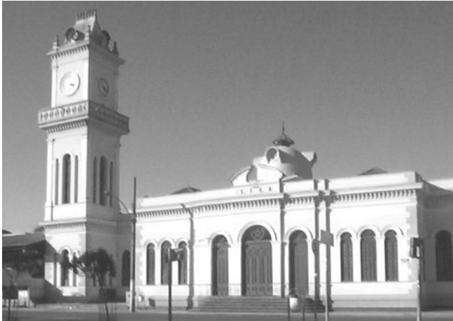
Figura 2.2.2.15: Estação da Estrada de Ferro D. Pedro II (Central). Fonte: Fonte: GIESBRECHT (2005).
