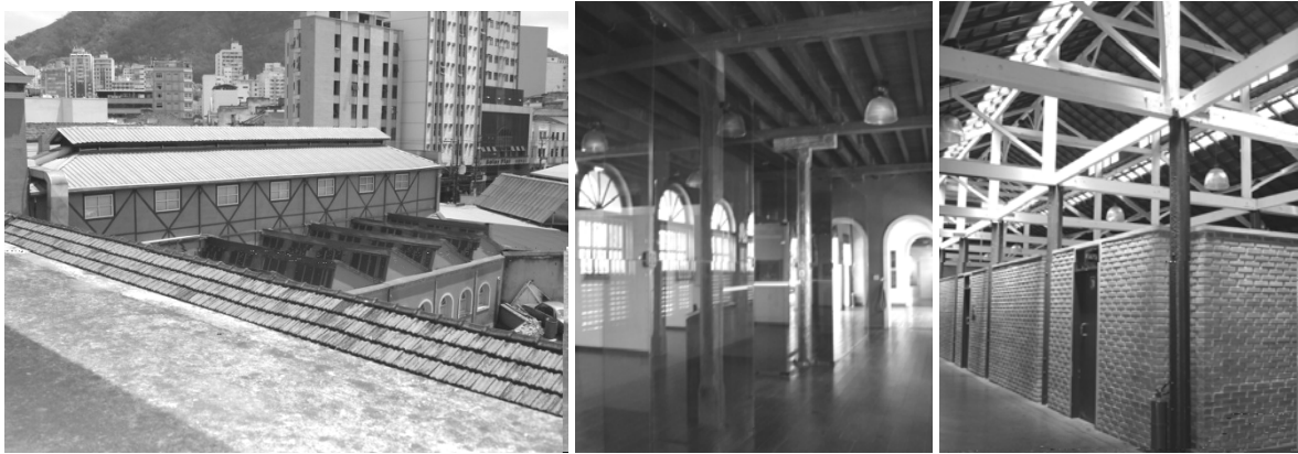
Figura 3.3.2.5: Seqüência de imagens: sistema de travamento do 2º piso; estrutura de sustentação em madeira da ala esquerda; estrutura de sustentação em ferro fundido da ala direita..
