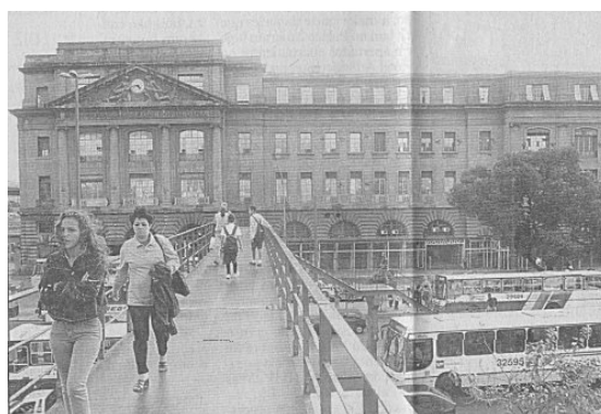
Figura 2.2.2.28: Estação Barão de Mauá, Rio de Janeiro. Fonte: GIESBRECHT (2005).
