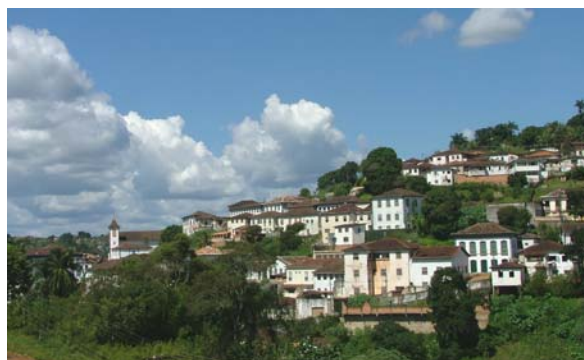
Figura 89. Vista parcial do conjunto urbano de Serro – forma de ocupação na encosta
