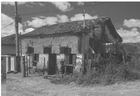
Figura 50. Casa térrea em processo arruinamento. Fonte: Segawa (2004) – foto de 197?
