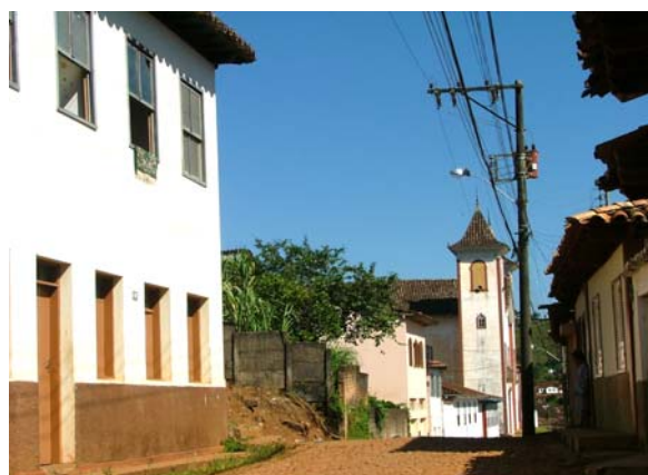
Figura 77. Lacuna referente a arruinamento de sobrado à rua Nelson de Senna, abril de 2006.
