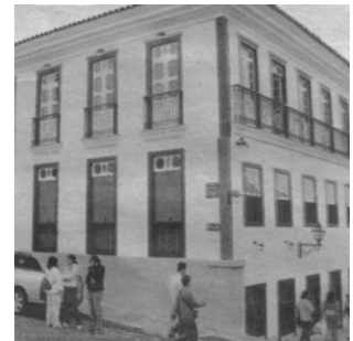
Figura 3. sobrado construído onde era o Hotel Pilão.
