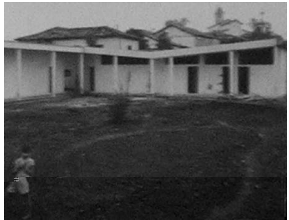
Figura 67. Grupo Escolar João Nepomuceno/Serro – Projeto de Alcides da Rocha Miranda. Pátio interno Fonte: IPHAN (2006)
