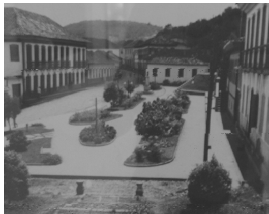
Figura 72. Praça João Pinheiro após 1943 Fonte: IPHAN (2006)
