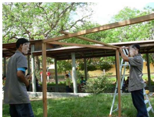
Figura 55 – Construção da estrutura de sustentação do “Recanto das emoções”
