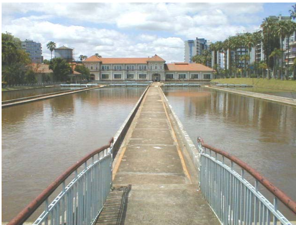
Figura 1: Hidráulica Moinhos de Vento 7
