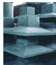
Blocos de fundação
