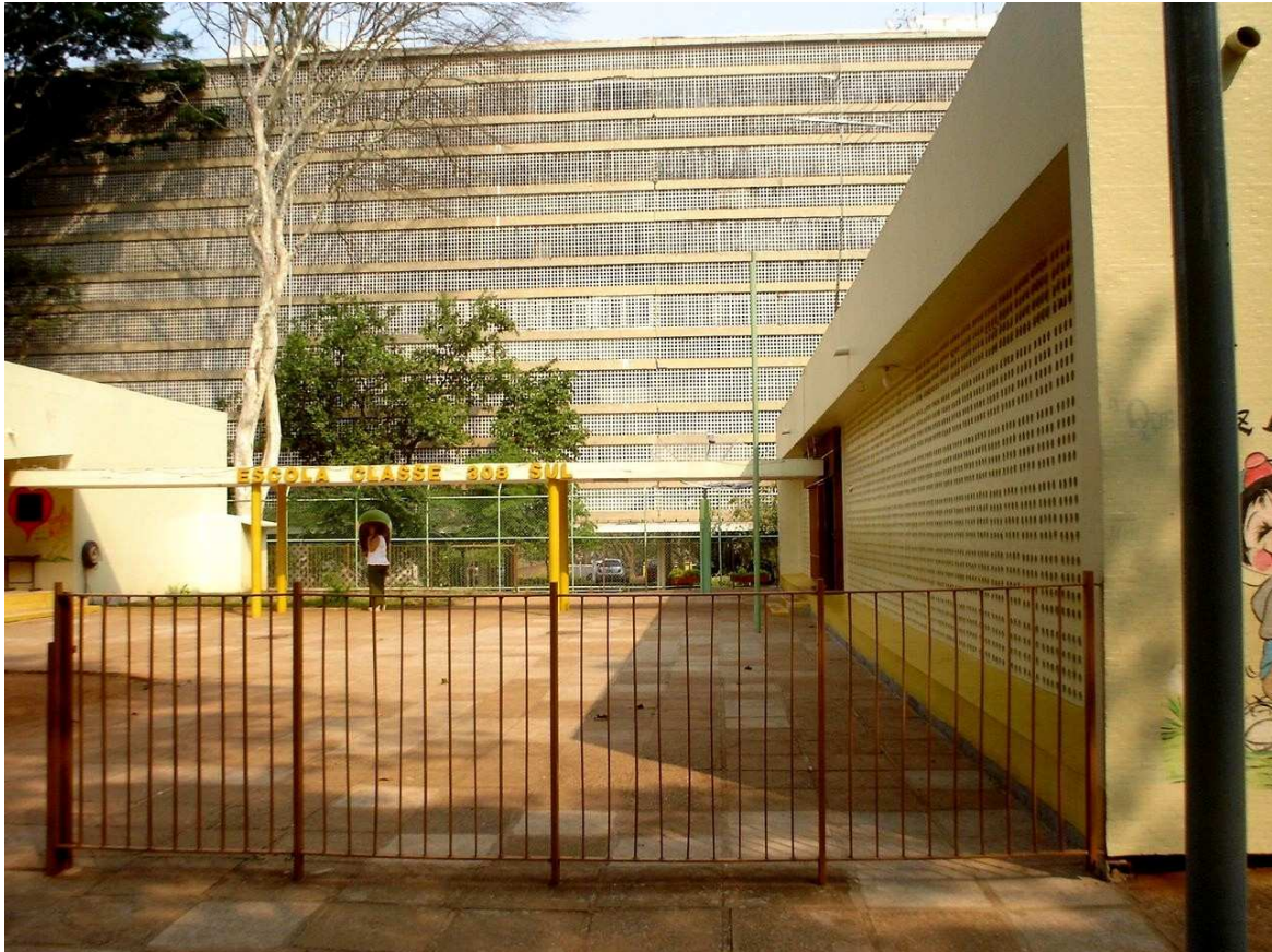
Fig. 14 Escola-classe 308 Sul. Vista do prédio administrativo, à direita, 2006. Foto do autor.
