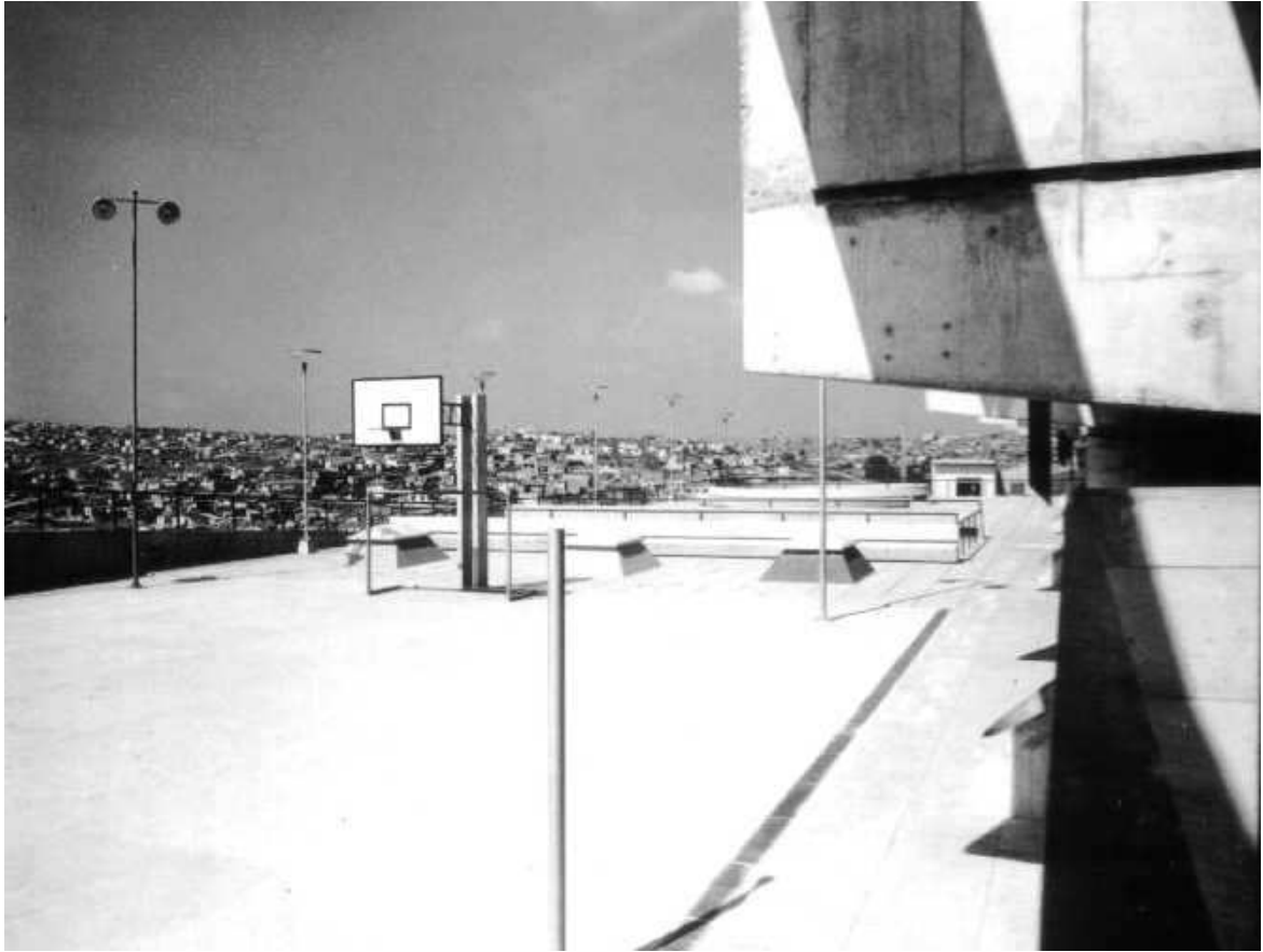
Fig. 26 GE Nova Utinga, 1972. Quadra poliesportiva, tendo ao fundo as três clarabóias de iluminação natural para o laboratório do piso inferior. Acervo pessoal de Dario Montesano.
