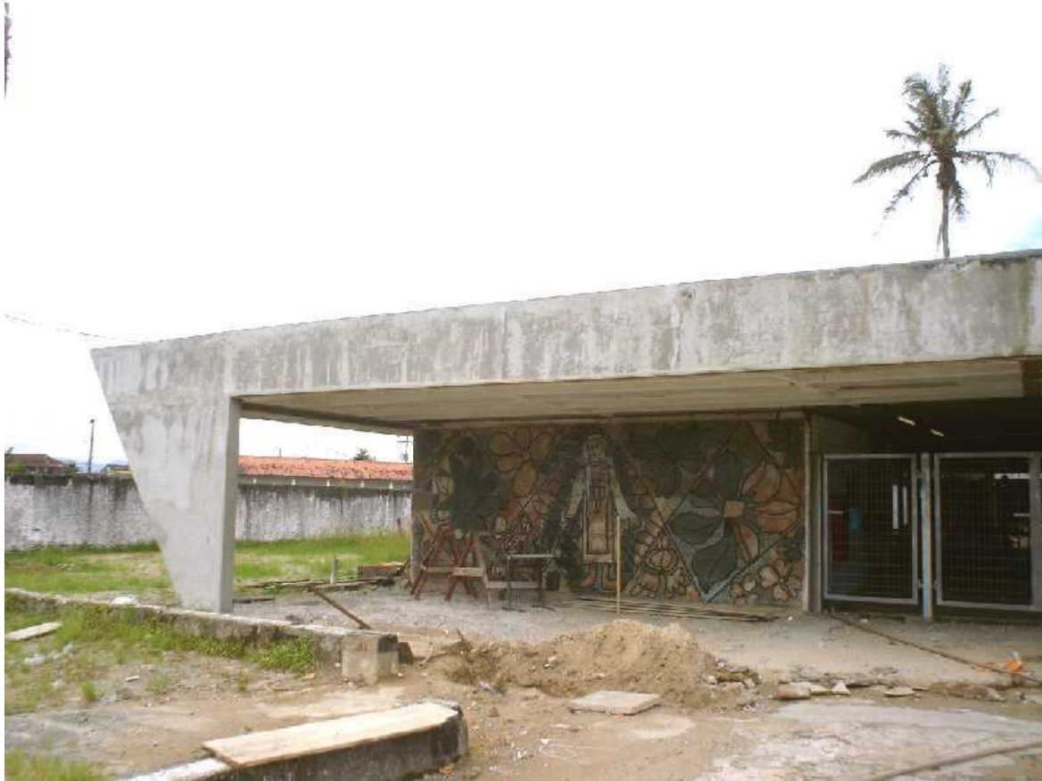
Fig. 47 Vilanova Artigas, arquiteto. Ginásio de Itanhaém, 2007. Fachada do edifício e seu mural. A escola está em processo de restauração. Foto do autor.
