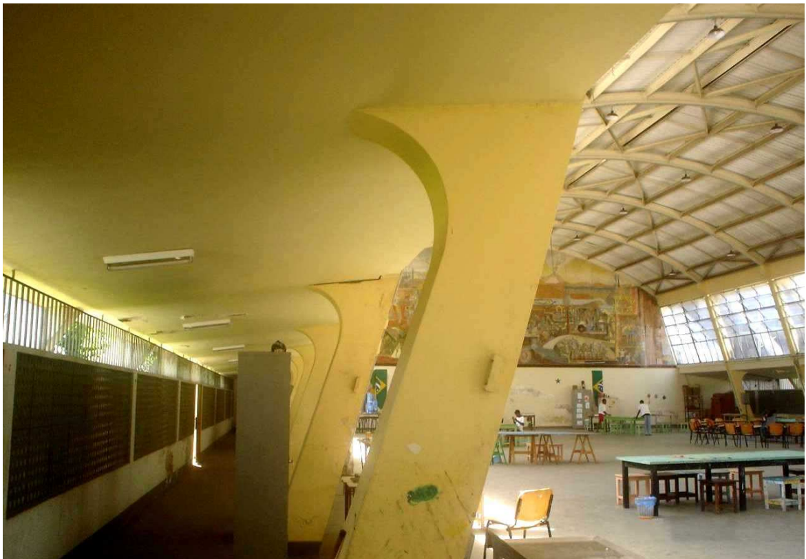
Fig. 32 CE Carneiro Ribeiro. Pavilhão de oficinas da escola-parque, 2006. Foto do autor.
