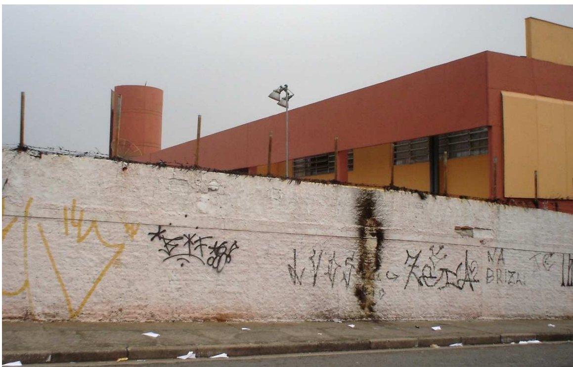
Fig. 67 GE Nova Utinga, atual EEPG Jocelyn Pontes Gestal, com muro e cercas de arame farpado, 2006. Foto do autor.
