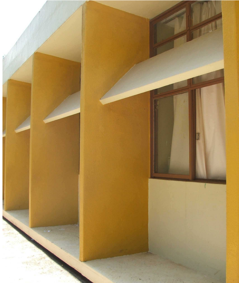
Fig. 15 Pavilhão de salas de aula da escola-classe. Detalhes das janelas, 2007. Foto do autor.
