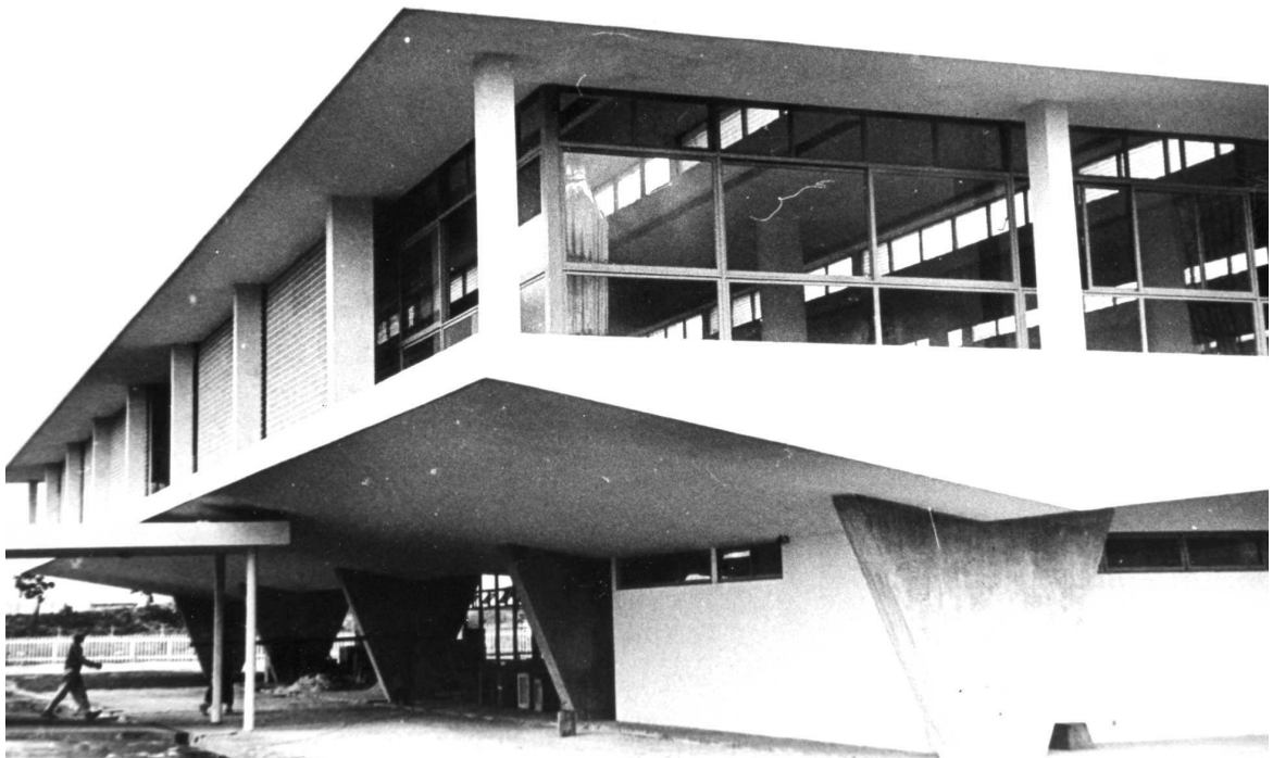
Fig. 54 José de Souza Reis, arquiteto. Pavilhão da Escola-Parque 307/308 Sul, 1959. Observe-se, em comparação com o Colégio Júlia Kubitschek (figura 55) as semelhanças dos blocos e da laje simples, no térreo. Fotobrás. Doação Ernesto Silva. DEPHA. Ampliações fotográficas: educação . Brasília. Pasta 18. (33 folhas.)
