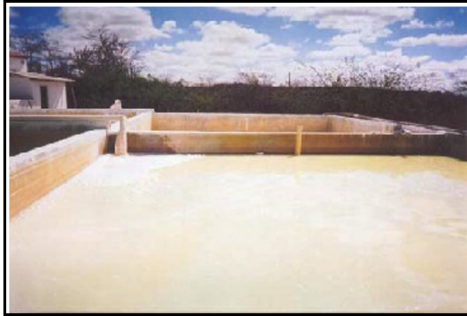
Figura 2.7 - Tanques utilizados para a decantação e sedimentação do Caulim [Fonte própria]
