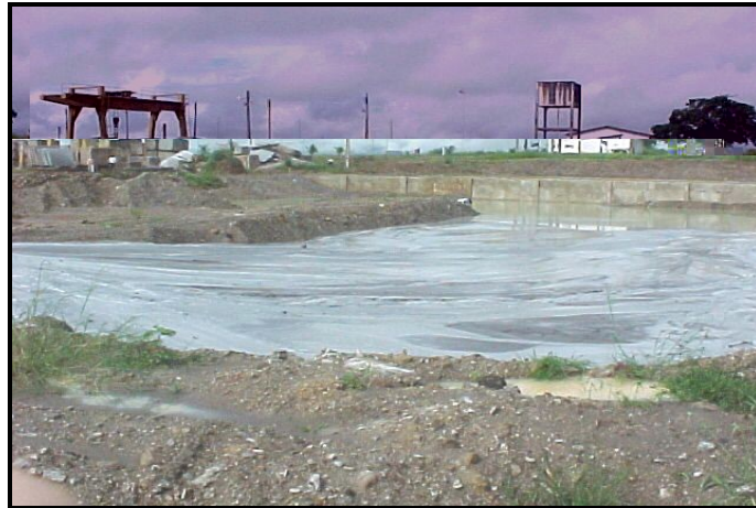
Figura 26 - Tanque de disposição final da empresa Polygram S/A [Fonte própria]
