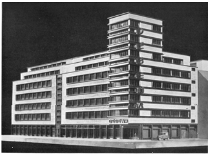
71-Projeto de Fritz Nathan, em 1928. Observa-se a liberação do térreo e uma base horizontal. Fonte: PLATZ, 1930, p. 429.
