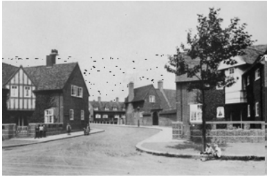
44 – Rua de um subúrbio inglês, composta por cottages isoladas e agrupadas.
