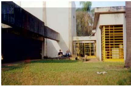
256 -Vista externa da casa, onde observa-se as diferentes alturas do pé-direito da casa.
