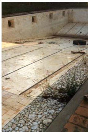
292-Vista da piscina, sem água, onde podemos perceber a iluminação que seria abaixo da água.
