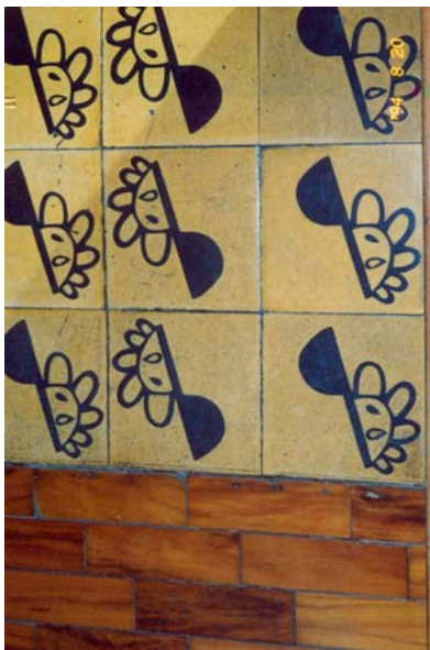
219 – Foto da junção de diferentes tipos de acabamento para o piso da casa nº2 da Rua interna, ladrilho hidráulico e madeira.
