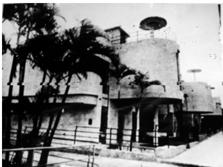
131 – Vista do conjunto de casas da Alameda Lorena, de Flávio de Carvalho. São Paulo, construída entre 1936 e 1938.
