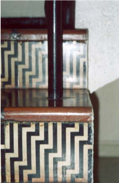
223 – Detalhe da escada e do peitoril metálico, na casa nº1052, Alameda Ministro Rocha Azevedo.
