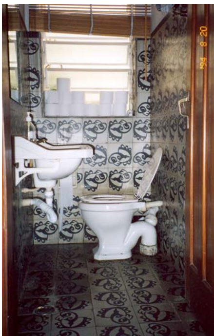
218 – Foto do banheiro térreo da casa nº2 da rua interna, ladrilhos originais.
