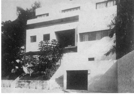
125 – Primeira casa modernista no Rio de Janeiro, na Rua Toneleros, de Warchavchik, aberta para exposição, em 1931.
