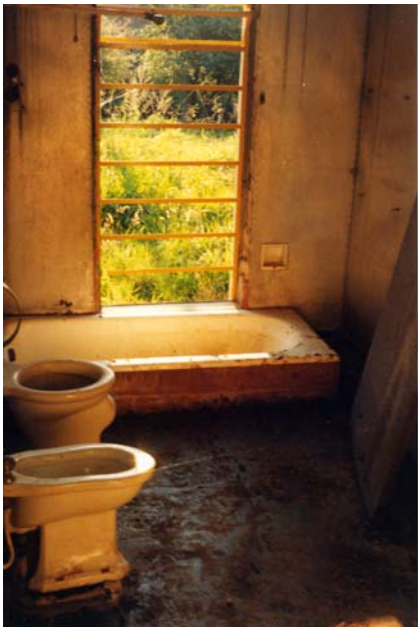
252 – Foto de um dos banheiros da casa com a esquadria voltada para o jardim da casa
