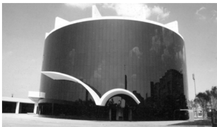
111- Edifício do Parlamento Latino Americano, de Oscar Niemeyer, 1989-1992. A estrutura da cobertura é externa.
