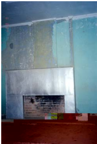
265 – Foto da lareira da sala revestida em alumínio.
