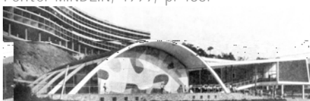
95- Conjunto Residencial de Pedregulho – Escola e Ginásio. Projeto de Affonso Eduardo Reidy, 1950-52. Rio de Janeiro. Fonte: MINDLIN, 2000, p. 149.
