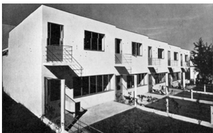
174-Casas em série de Weissenhof-Siedlung, Stuttgart, 1927. Vista da elevação com o acesso ao jardim. Projeto de J.J.P.Oud.
