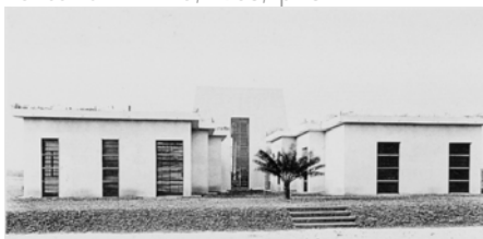
248-Vista da casa a partir da Sala Ancestral e da Biblioteca. Fonte: MATTAR, 1999,p. 50.
