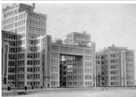
52-Casa das indústrias, na Ucrânia, 1929. Projeto de S.S. Serahimoff, M.D. Felguer e S.M. Kravetz. Arquitetura com a volumetria extremamente fragmentada. Fonte: PLATZ, 1930, p. 511.
