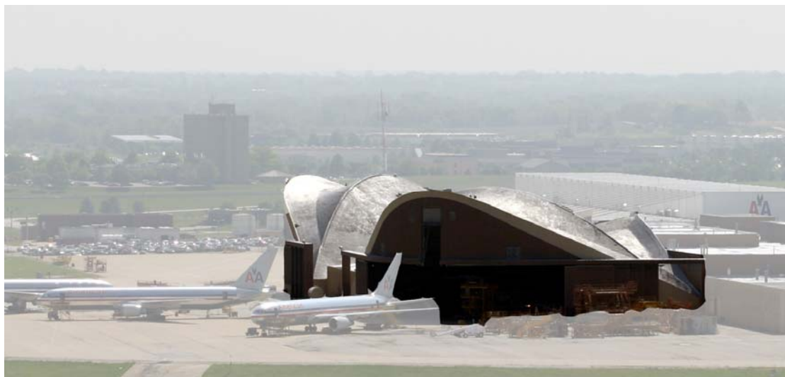
Figura 7.2 - Hangar da TWA no aeroporto da cidade de Kansas, EUA
