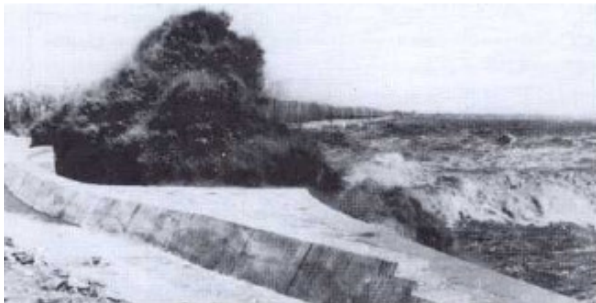
Figura 4.11: Influência da intensificação da reflexão da pororoca sobre um muro de contenção no rio Qiantang, China. (Simpson, 1997).
