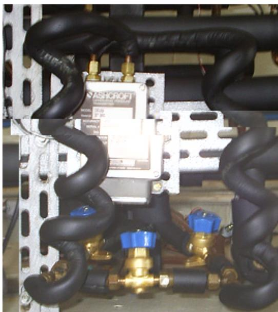
Figura 3.10. Foto do transdutor diferencial pressão instalado no sistema
