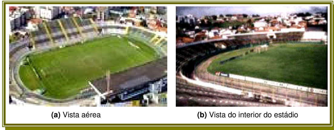
FIGURA 4.2 – Fotos do Estádio Orlando Scarpelli.
