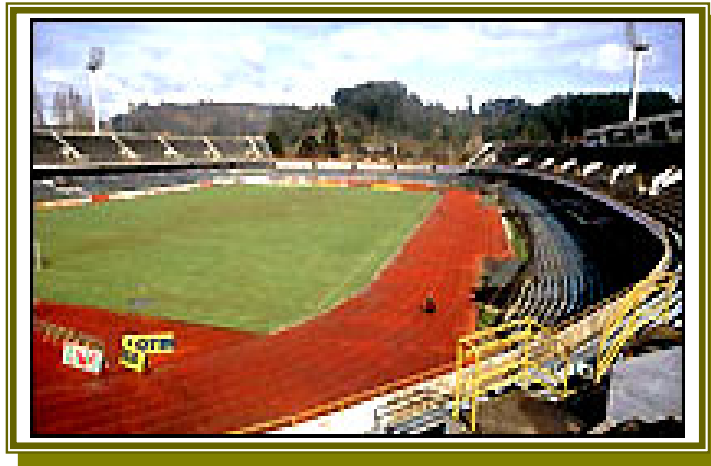
FIGURA 4.1 – Estádio de Concepción no Chile.
