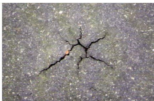
a) Trinca radial ou “vulcãozinho”
