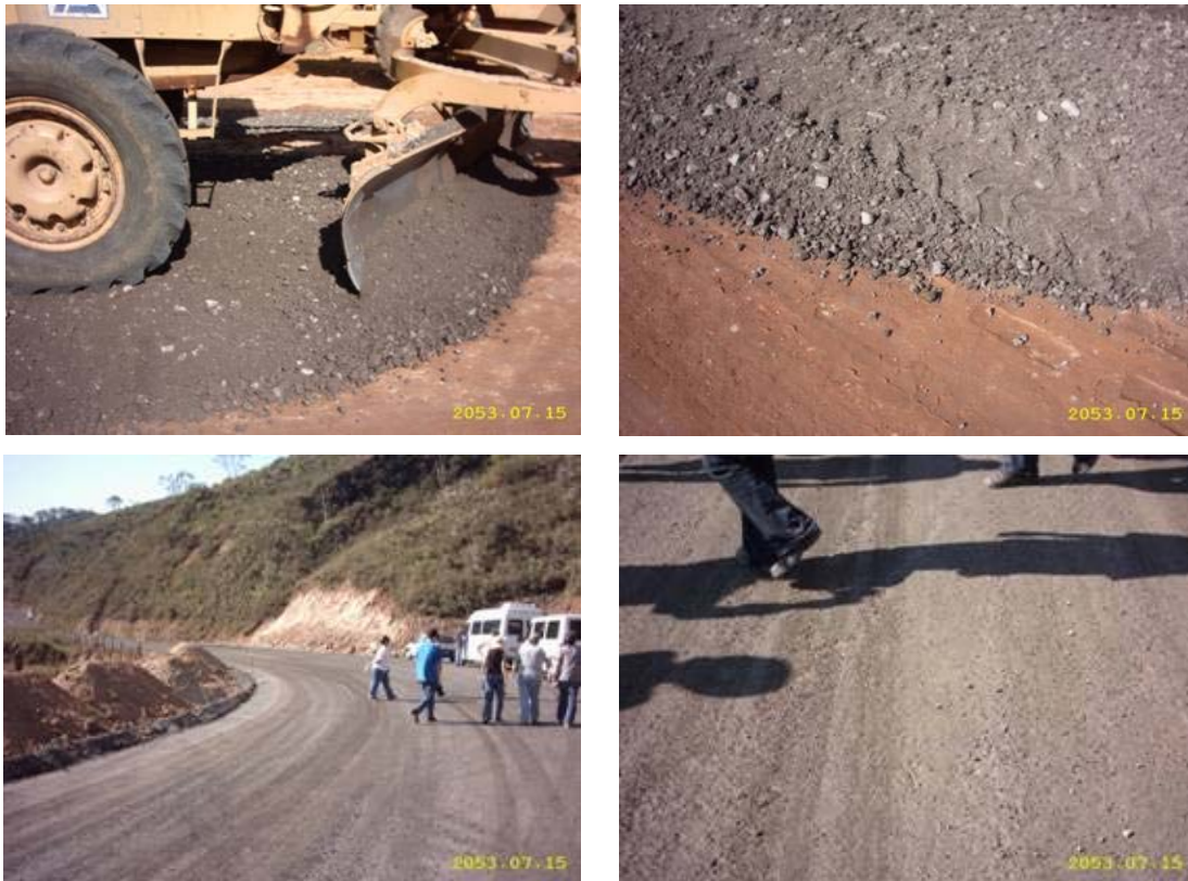
Figura 2.5 – Aplicação de escória de aciaria como base de pavimento rodoviário (RJ).
