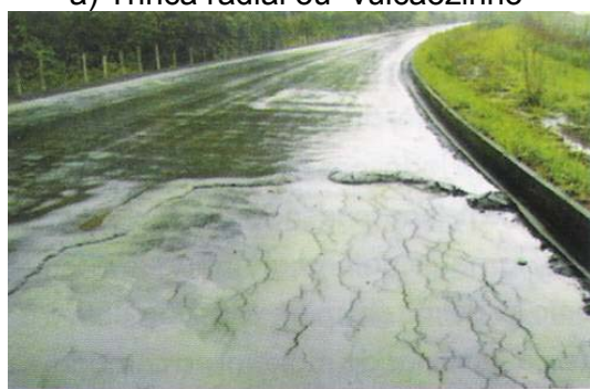
c) Solevações transversais e longitudinais ou “quebra-molas”
