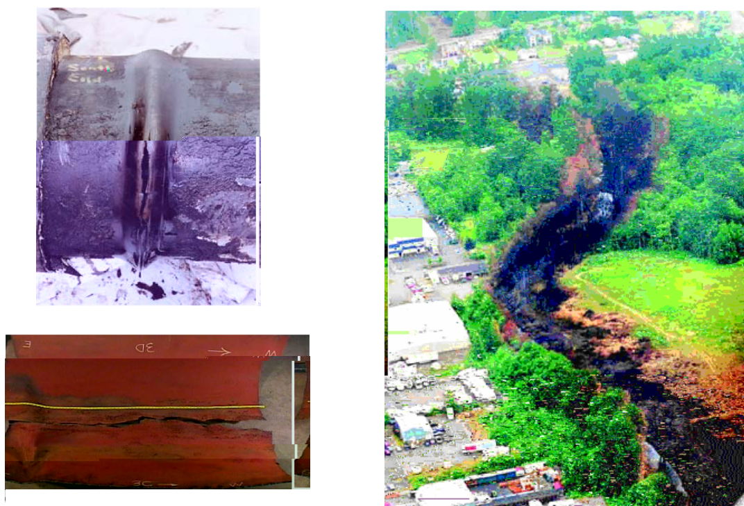
Figura 1-2 – Registro de danos em linhas de dutos.
