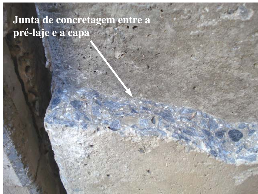
FIGURA 4.23 – Aspecto da aderência entre a pré-laje e a capa ao final do ensaio.
