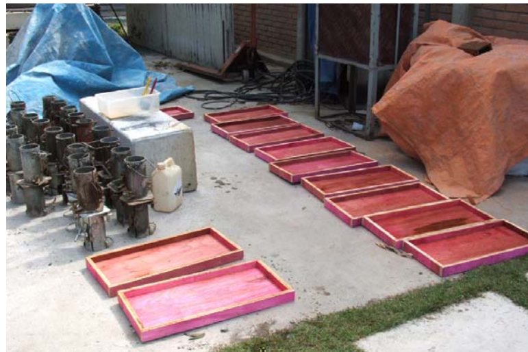
FIGURA 3.21 – Aplicação do desmoldante nas fôrmas da pré-laje.
