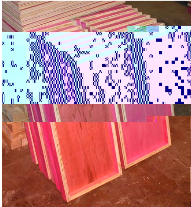
FIGURA 3.16 – Detalhes da fôrma para pré-laje de concreto.
