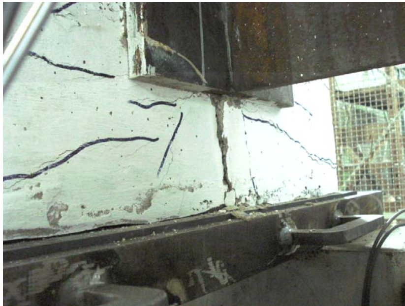
FIGURA 4.8 – Aspecto da ruptura da cunha de concreto logo abaixo do conector Crestbond-PL .
