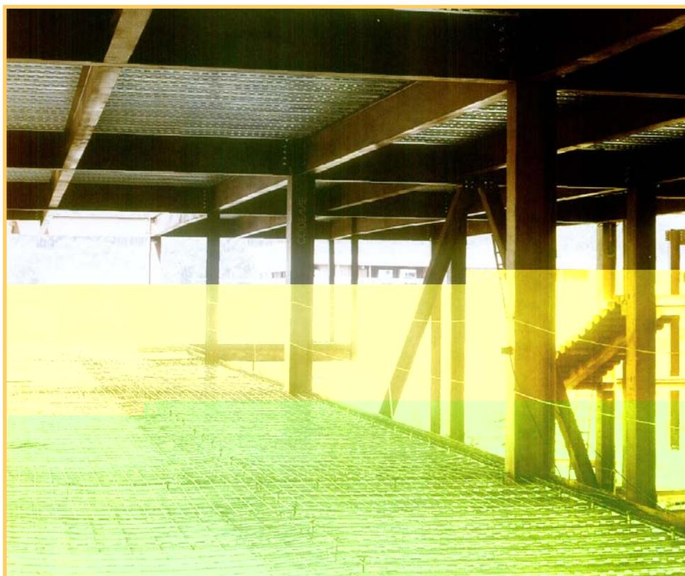
FIG. 1.2 – Modulação típica para formas metálicas convencionais
