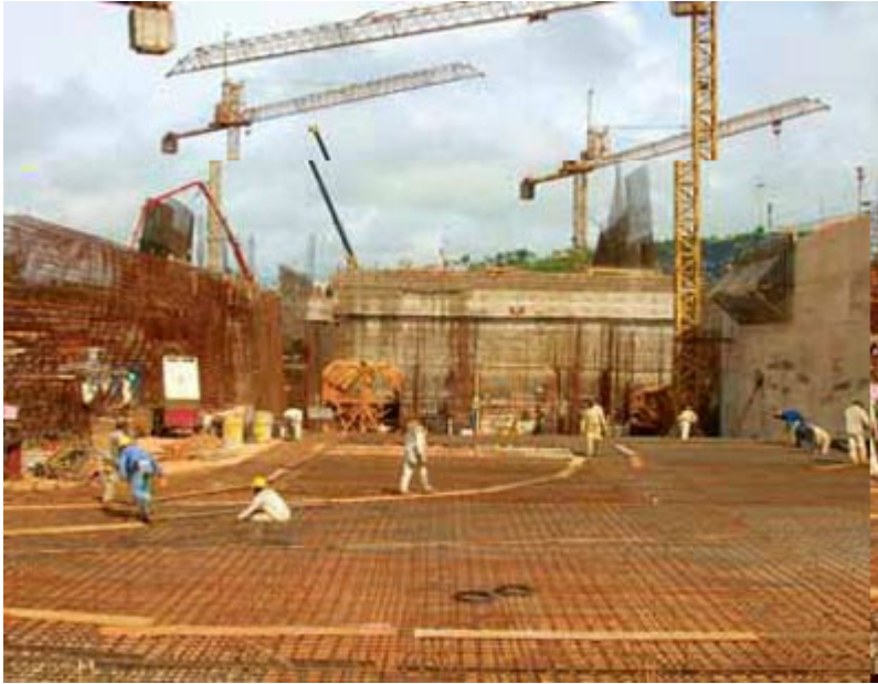
Figura 5.2 – Área do rebaixamento para implantação das estruturas da PCH Canoa Quebrada
