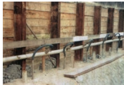
Figura 3.2 – Disposição das ponteiros no sistema de rebaixamento (Urbano, 1999)
