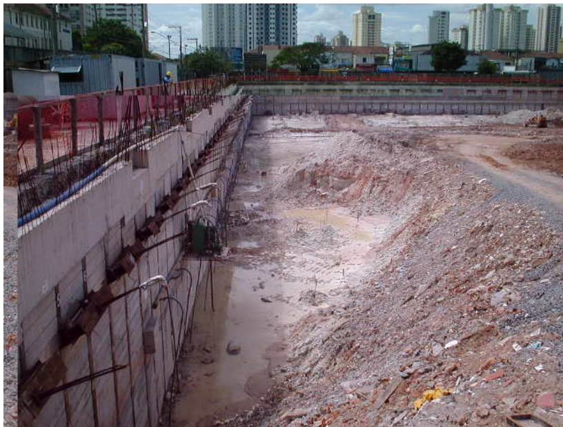
Figura 5.32-Sistema de rebaxamento com ponteiros no shopping Brooklin – São Paulo
