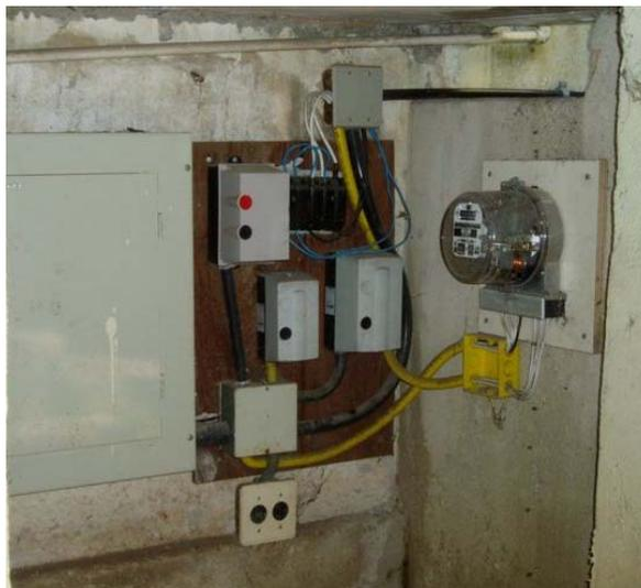
Figura 3.23 – Instalação elétrica do **LGMA/PUC-Rio**, com medidor de consumo individualizado para os sistemas de dessorção térmica
