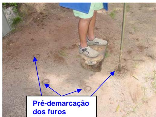
Figura 4.20 – Execução dos furos a trado, com locação pré-determinada, para instalação do bastonete e das sondas (vista aproximada)
