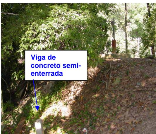
Figura 4.5 – Vista da face do talude, mostrando pedaços de vigas surgindo do solo
