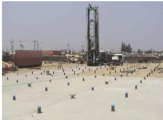
Figura 2.17 – Instalação dos bastonetes (2) (Bierschenk *et al*, 2004)
