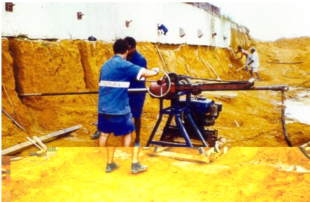
Figura 3.9 – Segunda fase de escavação.
