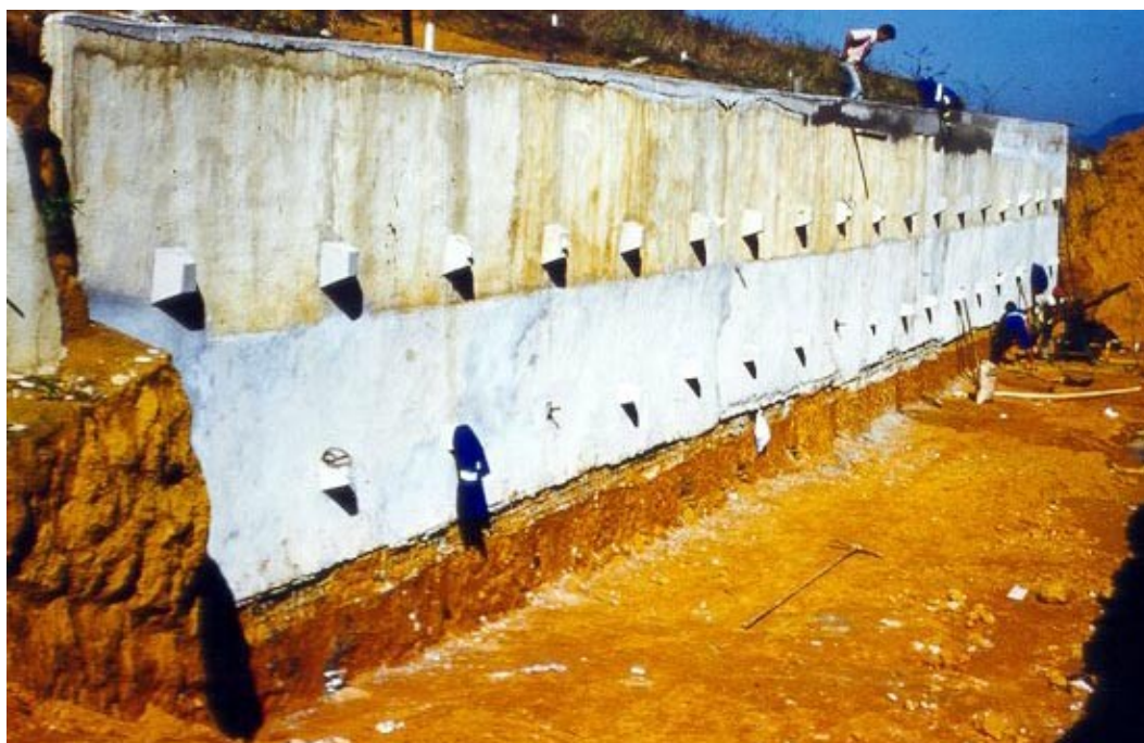
Figura 3.10 – Terceira fase de escavação.
