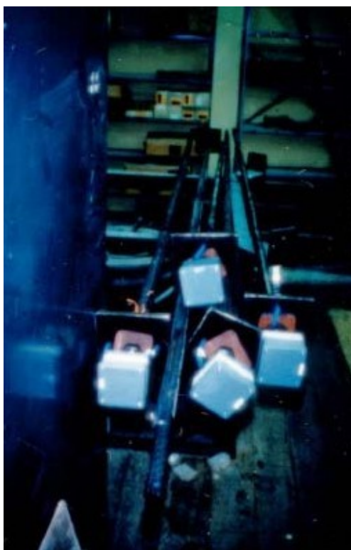
Figura 4.13 – Grupo de barras prontas para serem transportadas e instaladas no talude.
