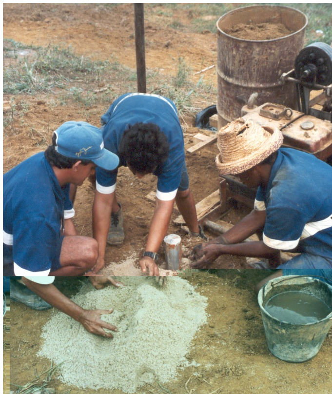
Figura 5.4 – Detalhe da aplicação da areia lavada nos furos.
