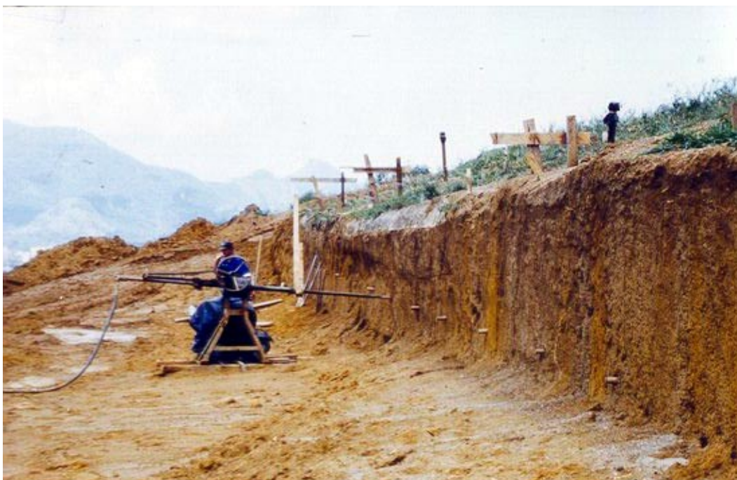
Figura 3.8 – Primeira fase de escavação.
