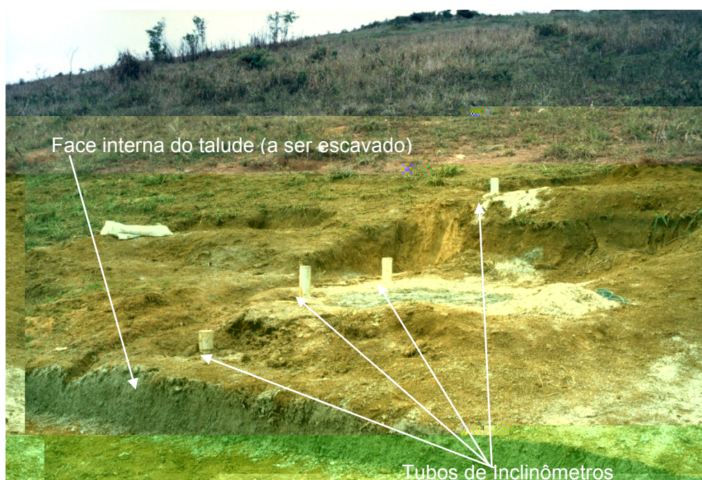
Figura 3.7 – Vista do posicionamento dos tubos de inclinômetro, já instalados.
