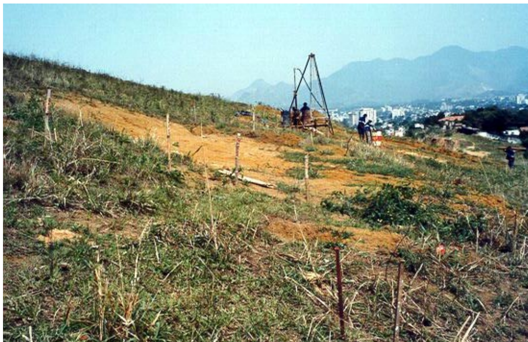
Figura 3.6 – Situação inicial do talude.
