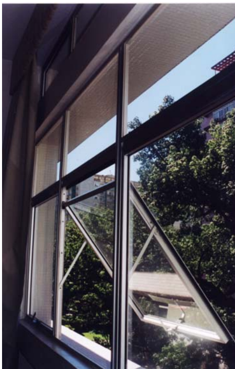
FIGURA 4.11 – Vista interna da janela da internação FONTE: Foto da autora.
