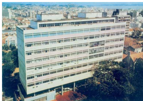
FIGURA 4.2 – Vista panorâmica a partir do Hospital Fêmina FONTE: Arquivo do arquiteto Irineu Breitman.
