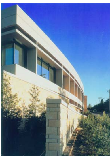
FIGURA 2.1 – Harrison Memorial Hospital FONTE: MALKIN, 1992, p.139.
