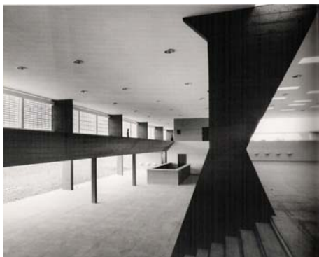
Pátio coberto e passarela sobre a área da cantina
