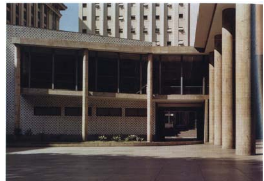
Acesso à rua da Imprensa e volume do auditório
