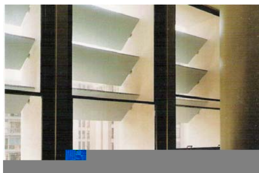
Detalhe dos brises na face norte.
