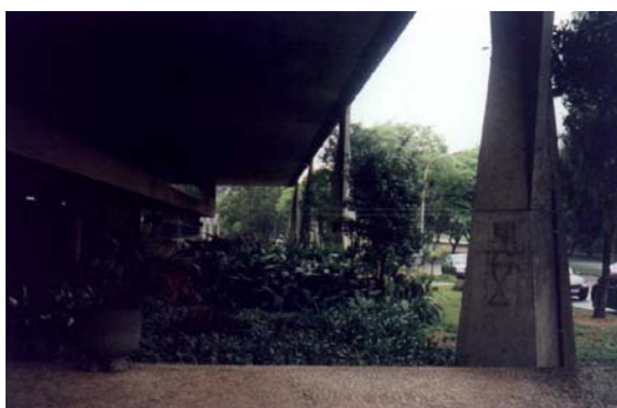
Foto tirada da rampa de acesso voltada em direção à face sudeste.
