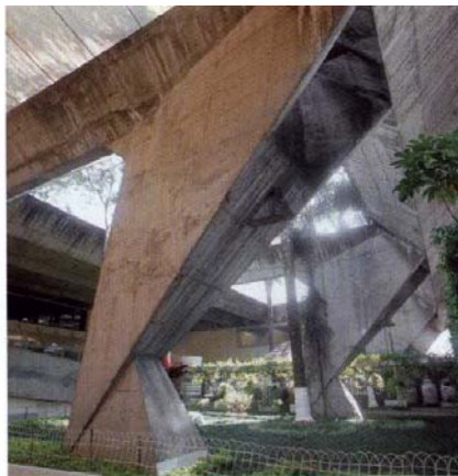
Detalhe da estrutura
