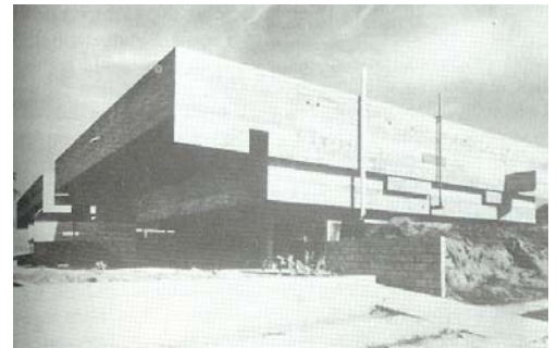
FIG.166: Paulo Mendes da Rocha. Casa do arquiteto. São Paulo, 1964.
