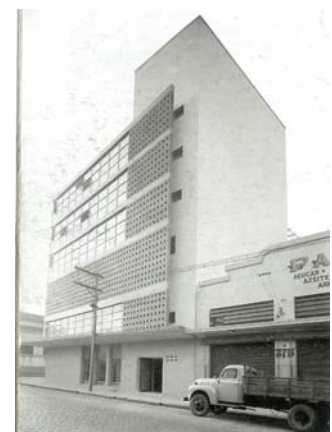
FIG.175: Rino Levi. Edifício Concórdia. São Paulo, 1955-57.
