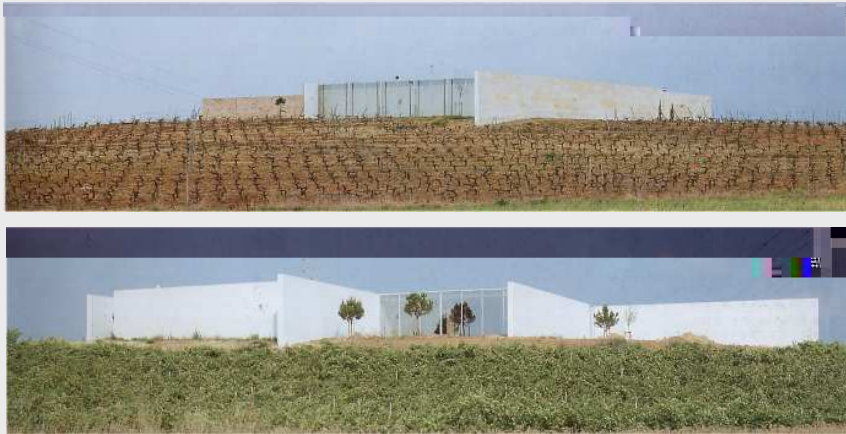
Fig.4.4 e 4.5 Vista de dois lados opostos da Casa Alcanena. Eduardo Souto de Moura.
