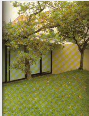
Fig.7.41 Muro configurado como plano autônomo avança para além dos limites internos da edificação isolando o pátio do serviço do pátio dos dormitórios.
