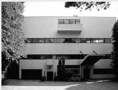
Fig. 1.9 Villa Stein, Garches. Le Corbusier, 1927. Fachada Frontal.
