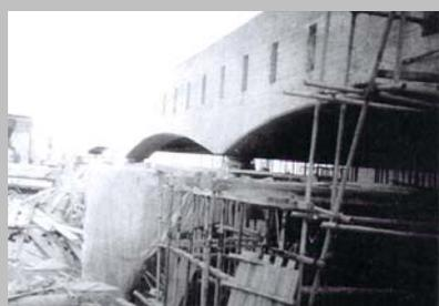
Figura 72 – Cobertura em concreto aparente- arcadas estruturais, pilares 3 e 4.
