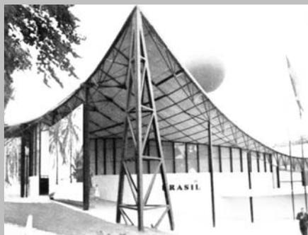
Figura 40 – Apoio metálico.
