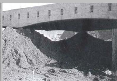
Figura 73 – Cobertura em concreto aparente- sistemas de pré-tensão.
