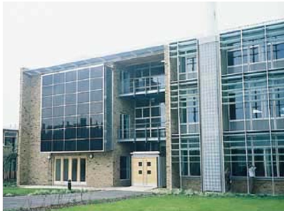
Figura 33 - Painel fotovoltaico na fachada da sede do Building Research Energy, em Londres: uso de a luz solar.
