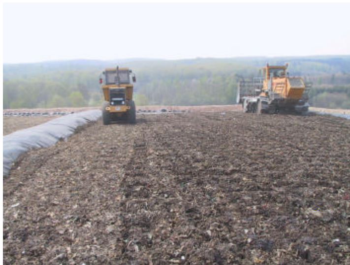
Foto IV.18 – Vista dos resíduos sólidos (pré-tratados) depositados no Aterro Sanitário de Buchen - Alemanha.
