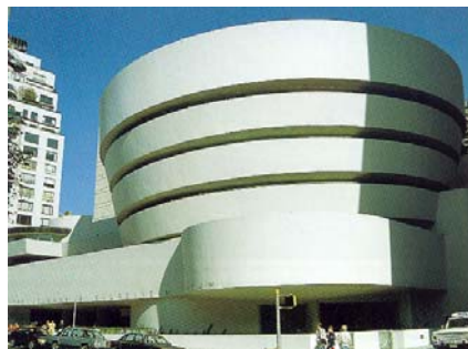
Figura 57 – Frank Lloyd Wright – Museu Guggenheim, Nova Iorque. Fonte: GYMPEL, Jan, Historia da Architectura – da Antiguidade aos nossos dias , 2000, p. 102.
