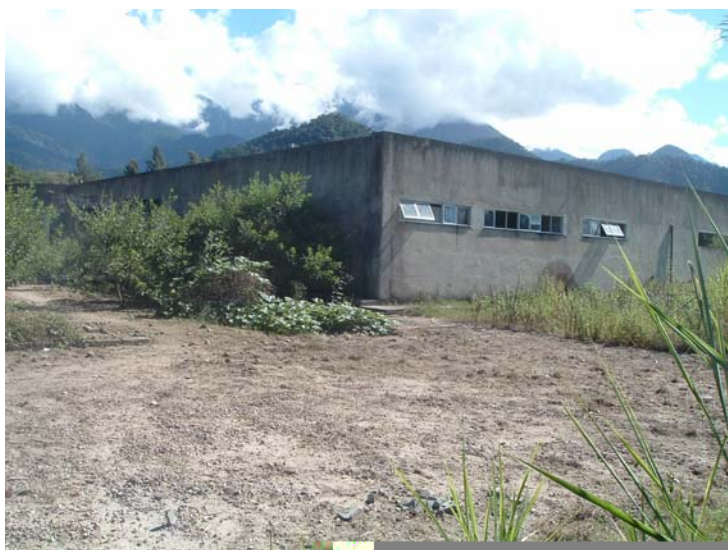
Fig. 39 – Construção de hospital, paralisada. Iniciada em 2003, no Centro.
