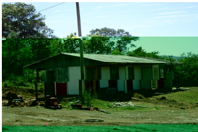
Figura 08 – Instalações destinadas ao refeitório, vestiários e sanitários - (Foto : Acervo do Autor).
