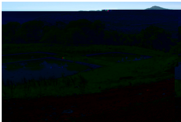
Figura 05 – Lagoas de recolhimento e contenção do chorume - (Foto : Acervo do Autor).
