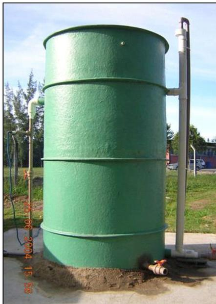
Figura 4-1: Reator anaeróbico compartimentado (RAC).
