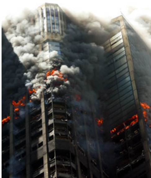
Figura 1.1 – Incêndio no Edf. Parque Central – Caracas, Venezuela (2004)
