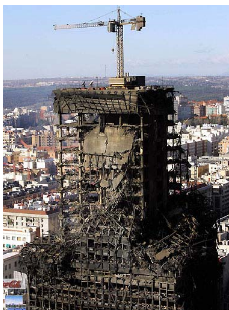
Figura 1.2 – Edf. Windsor após o incêndio Madrid, Espanha (2005)
