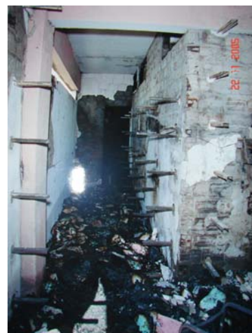
Figura 8 – Hall de acesso ao WC feminino
