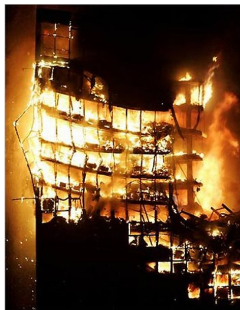
Figura 1.3 – Incêndio no Edf. Windsor Madrid, Espanha (2005)
