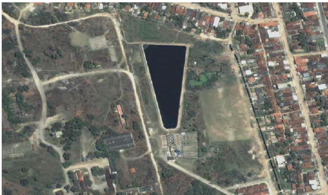
Figura 3.2. Vista geral da ETE-Mangueira e de parte da bacia de esgotamento (out/2005)
