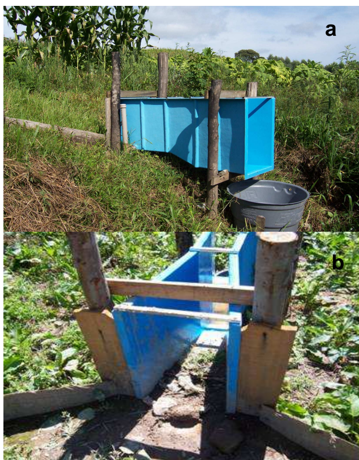
Figura 31. Aspecto da calha Parshall instalada a campo na forma de “estaleiro” (a) e do dique de tábuas construído na entrada da calha (b).
