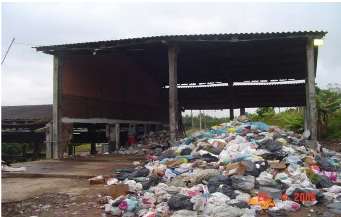
Fig. 17 – Pátio de Recepção da Usina ( acervo do autor, 2006)
