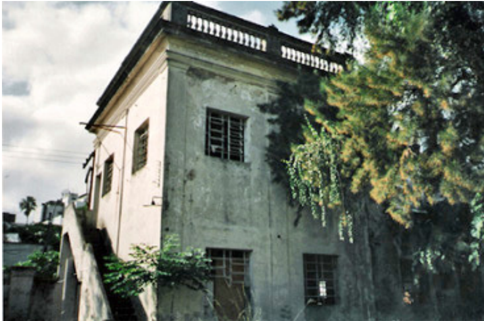
Figura 38 – Maior prédio do Casarão visto do pátio interno (abril de 2002).
