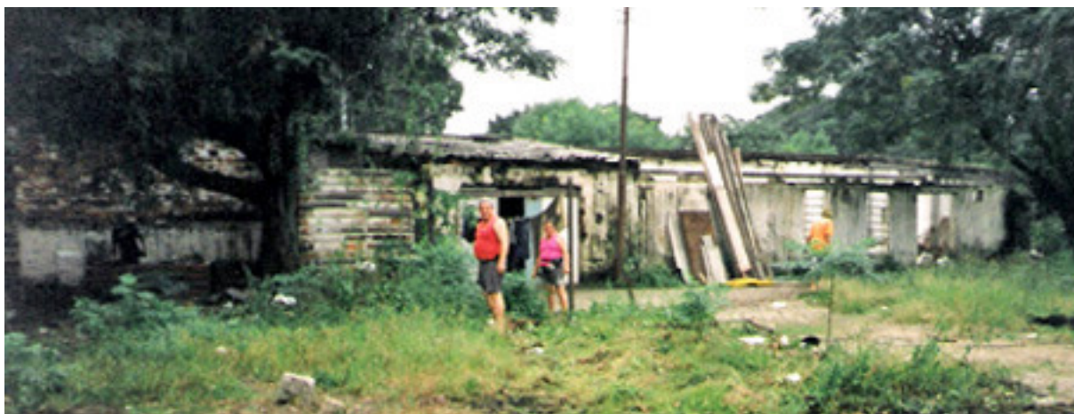
Figura 65 – João Nedi e Clair durante a construção de sua casa (abril de 2002).
