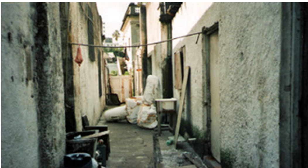
Figura 105 – Corredor de acesso à futura casa de Vildemar (abril de 2002).
