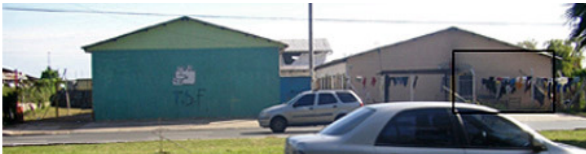
Figura 69 – Casa de passagem da Av. Padre Cacique em vista frontal (02/06/2006).
