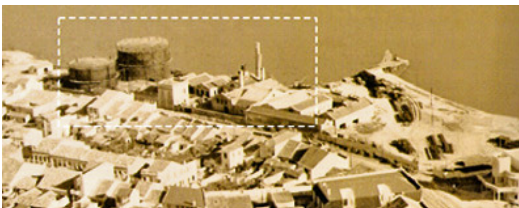
Figura 115 – Foto com destaque da área total do antigo gasômetro (1937). 94
