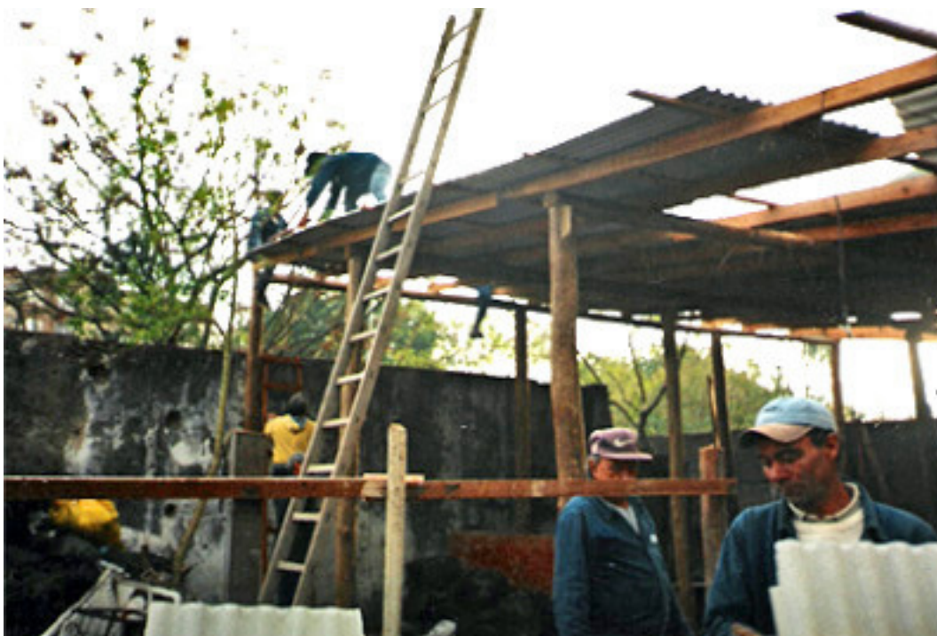
Figura 81 – Desmontagem do galpão de reciclagem pela Prefeitura (18/09/2003).
