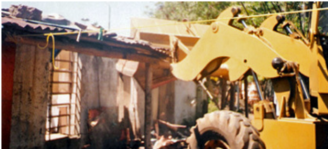
Figura 86 – Derrubada da casa de Sebastião e Márcio no Casarão (16/10/2003).
