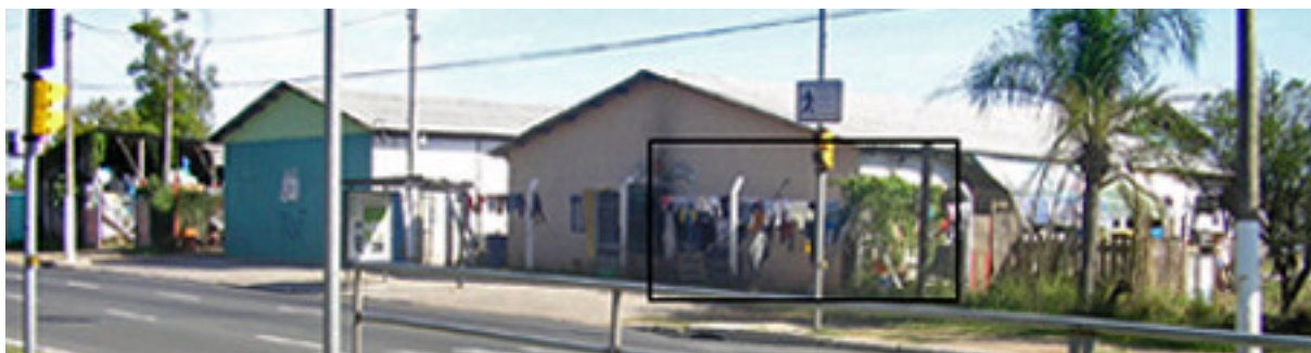
Figura 70 – Casa de passagem da Av. Padre Cacique em vista diagonal (02/06/2006).
