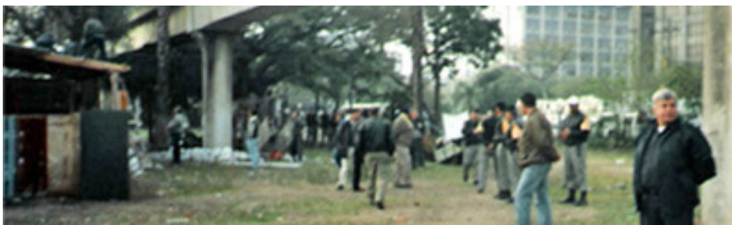
Figura 110 – Guarda Municipal e BM na desmontagem do galpão (18/09/2003).
