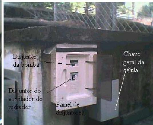
Figura 18: O painel de disjuntores para a bomba d'água e para o ventilador do radiador.
