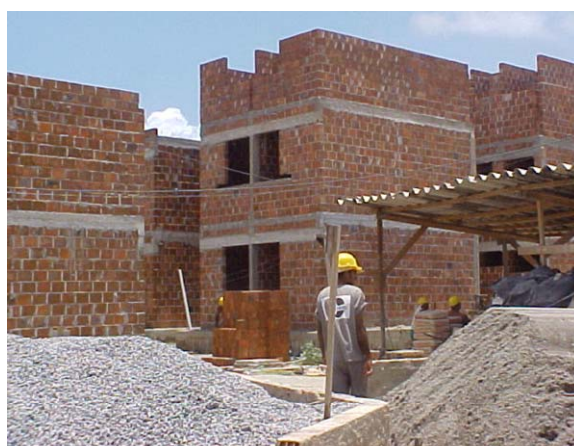
Foto 04 – Conjunto em construção
