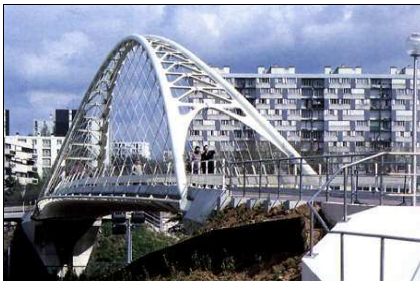
Figura 1.2 - Passarela Oudry-Mesly [2]– França.
