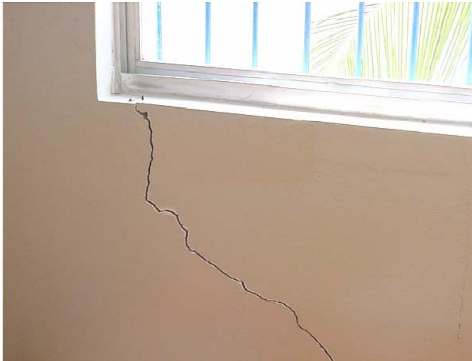
Figura 1.1. Fissura provocada pelo colapso do solo numa vista do interior de uma sala de aula. (Souza Neto, 2004).
