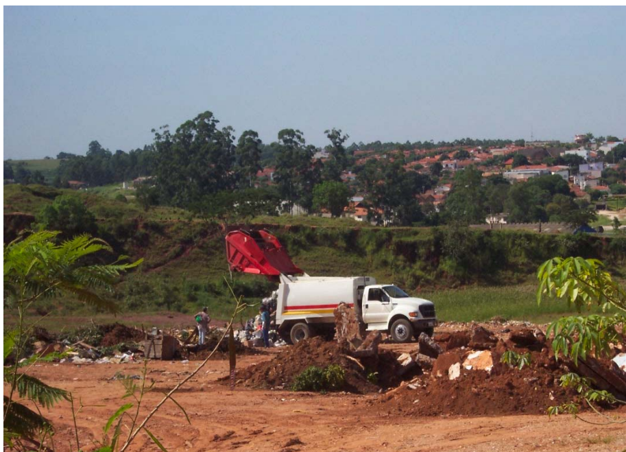
Figura 20 - Foto do depósito da coleta domiciliar (nov., 2004).
