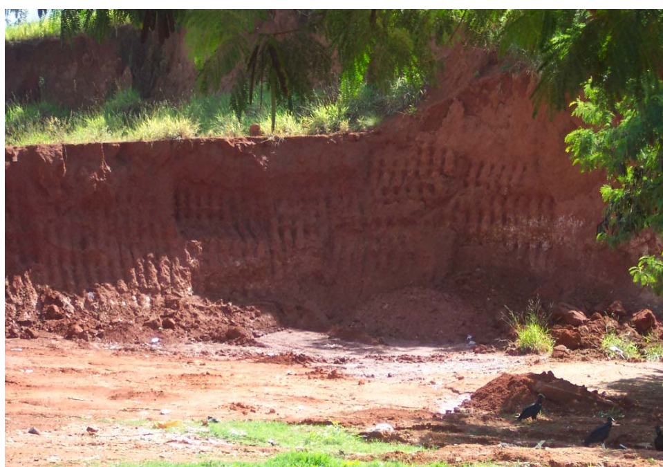
Figura 31 – Foto de escavação para retirada de material de cobertura (abril, 2005).
