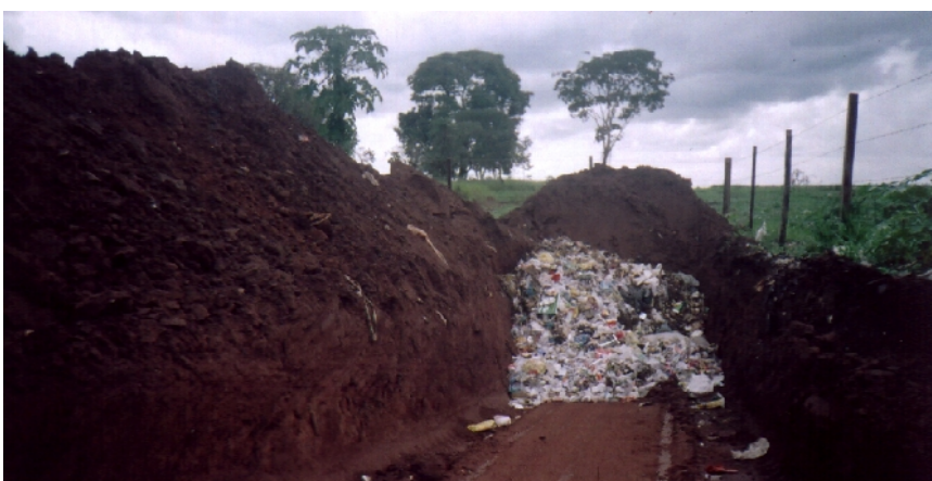
Figura 28 - Vista parcial da vala de rejeitos
