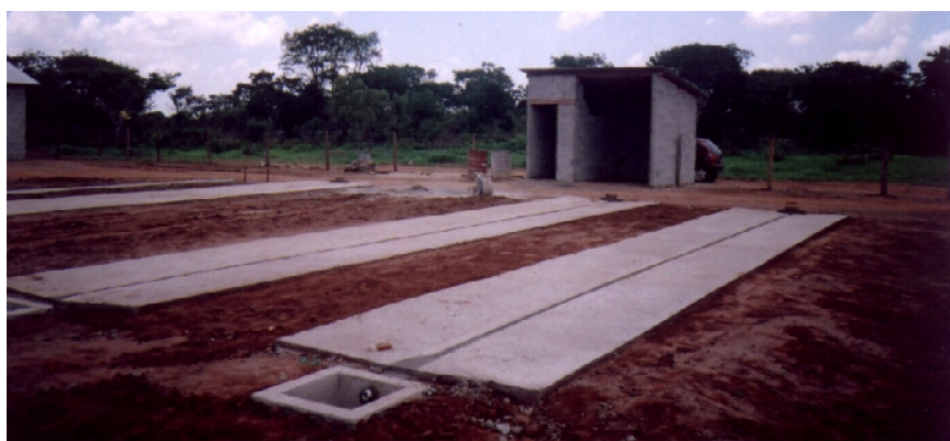
Figura 26 - Vista parcial do pátio de compostagem
