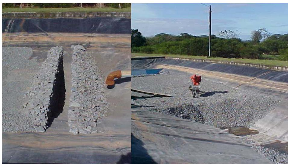
(a) pedras rachinha usadas para ancorar a barreira. (b) execução do leito de pedra
